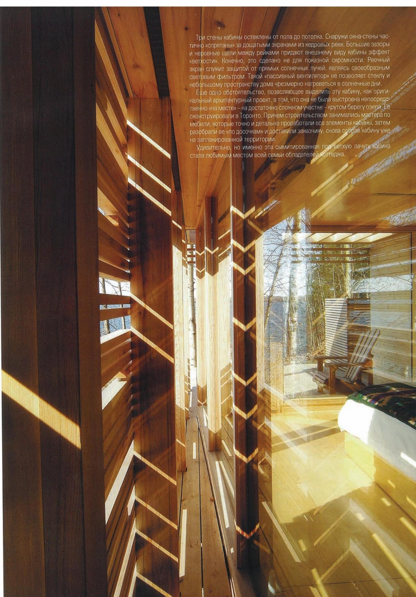
Три стены кабинны остеклены от пола до потолка. Снаружи окна-стены частично «спрятаны» за дощатыми экранами из кедровых реек. Большие зазоры и неровные щели между рейками придают внешнему виду кабинны эффект «ветхости». Конечно, это сделано не для показной скромности. Реечный экран служит защитой от прямых солнечных лучей, являясь своеобразным световым фильтром. Такой «пассивный вентилятор» не позволяет стеклу и небольшому пространству дома чрезмерно нагреваться в солнечные дни.
